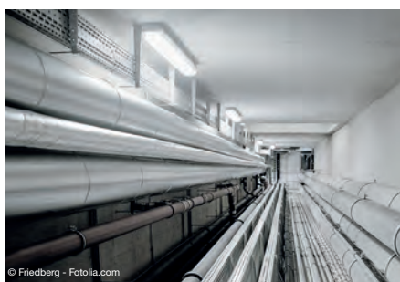
Befestigung von Kabelschächten
