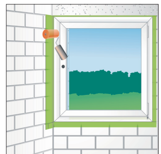
Bild 10: Folie mit Andruckroller anrollen
